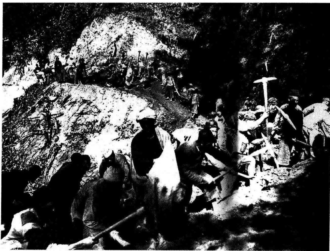
↑修筑滇缅公路全凭民工“手工”开挖，几乎没有使用任何机械
